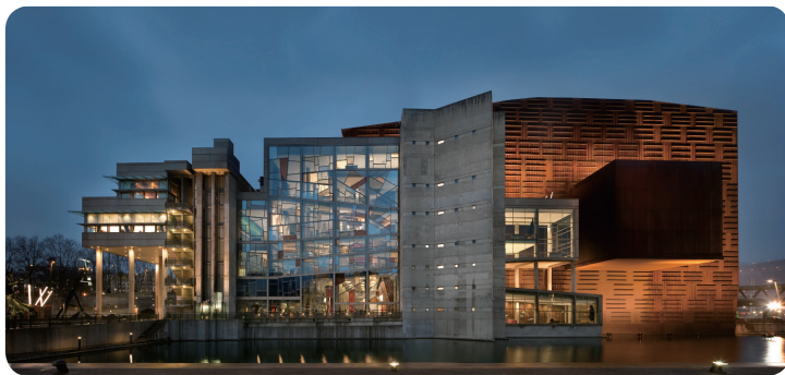
Vue extérieure du centre de conférence Euskalduna
